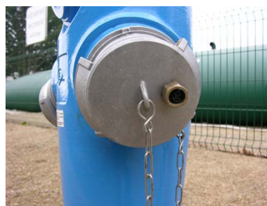
Poteau d'aspiration de 150 mm muni d'un « Airclap »
